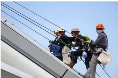
Trabajos en altura
